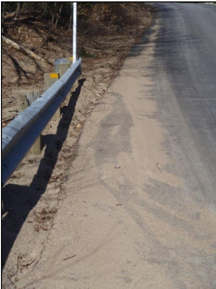
Photo 3 : Ruissellement de surface et transport de sédiments (abrasifs), route 351.
