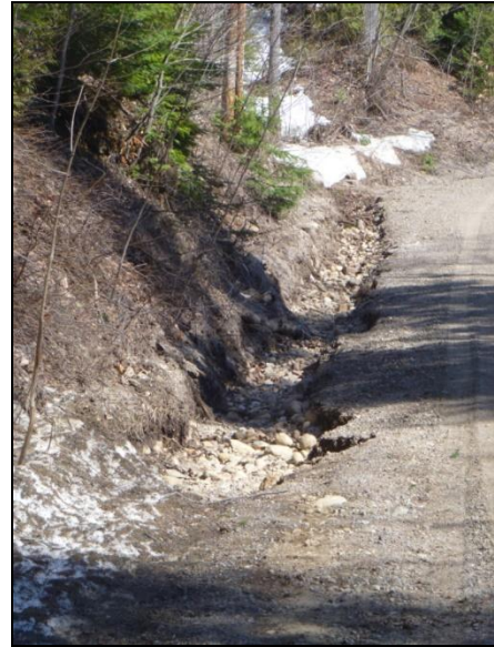
Photo 2 : Ruissellement de surface et écoulement préférentiel (Voir site n° E13, carte 3 et annexe 3).
