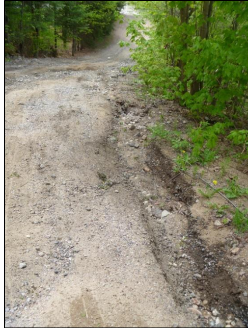
Photo 2 : Ruissellement de surface et écoulement préférentiel, route Robichaud (Voir site n° E3, carte 3 et annexe 3).
