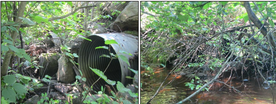
Photos 7 et 8 : Le ponceau n° PERM-41 est situé à Saint-Alexis-des-Monts et traverse l'exutoire du lac Lavallée (carte 4).
