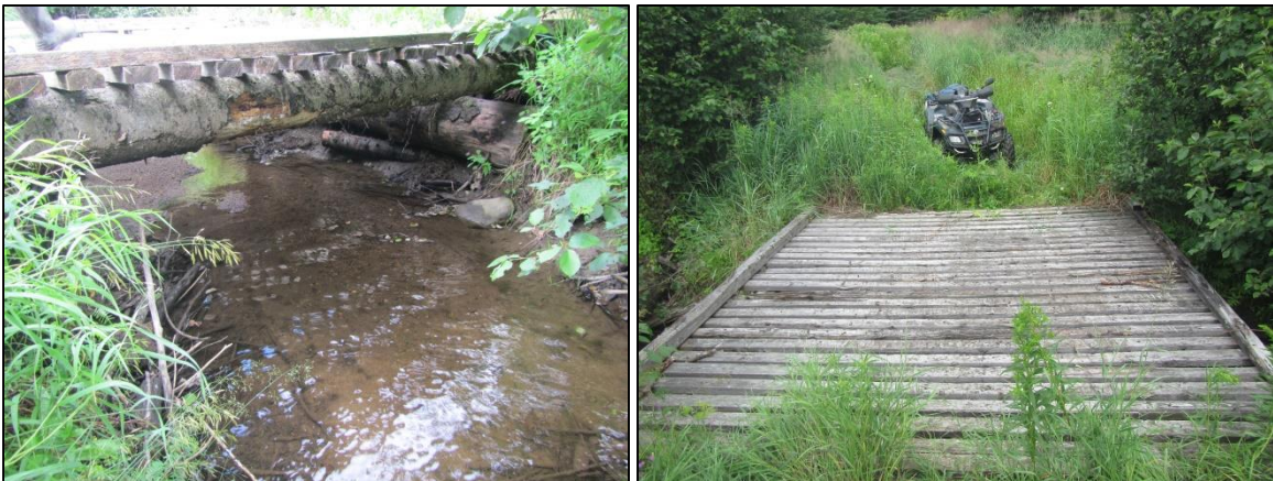
Photos 17 et 18 : Le pont de bois n° PERM-47 est situé à Saint-Paulin et traverse un cours d'eau en milieu agricole en friche (carte 8).
