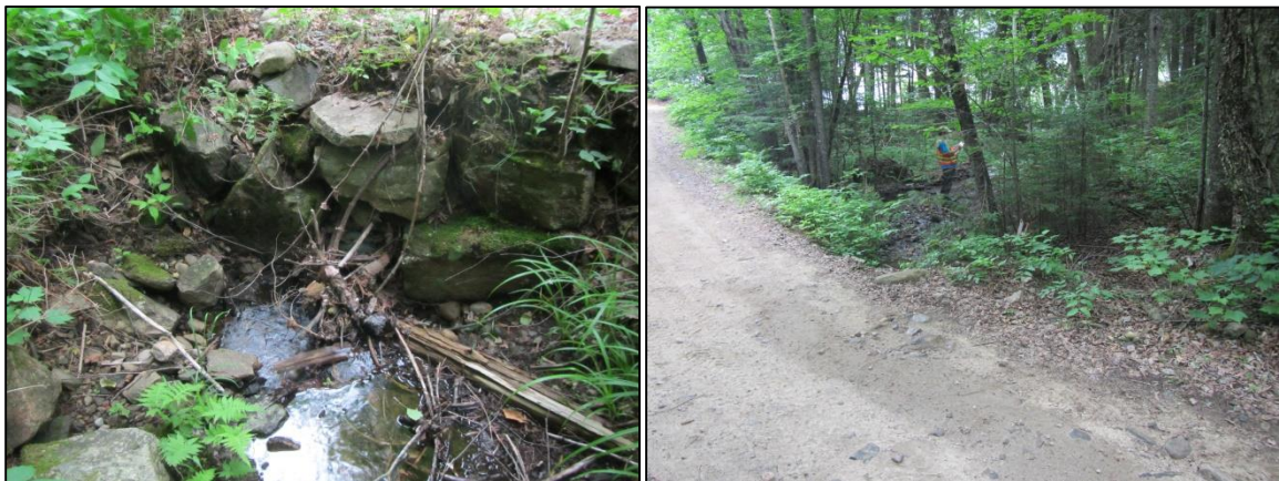
Photos 3 et 4 : Le ponceau n° PERM-25 qui traverse un tributaire (ruisseau) du lac Larose est situé à Saint-Alexis-des-Monts (carte 3).
