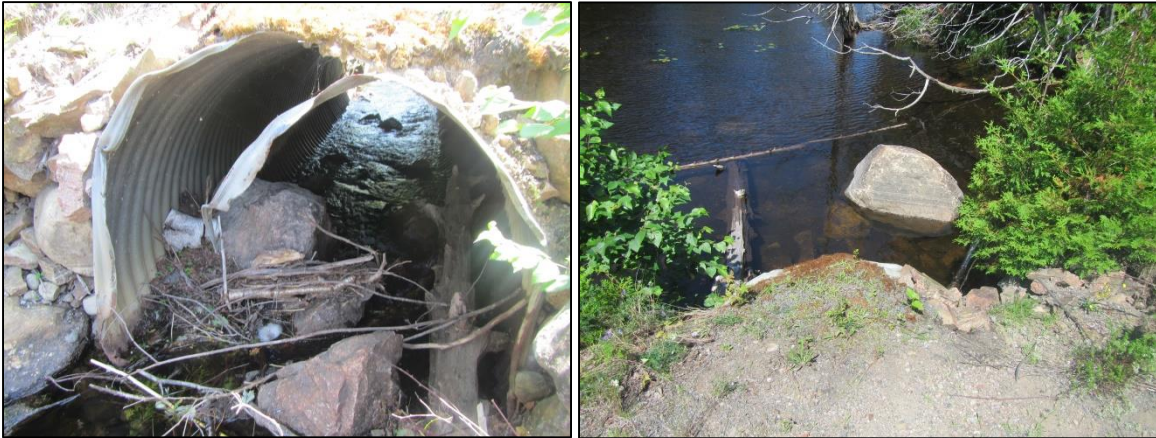
Photos 15 et 16 : Le ponceau n° PERM-38 est situé à Saint-Alexis-des-Monts et traverse un tributaire du lac à l'Eau Claire (carte 7).
