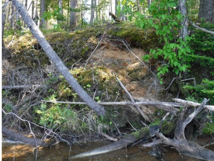
Figure 2 : Décrochage important en rive dans une pente forte (site A26) à Saint-Alexis-des Monts en 2019
